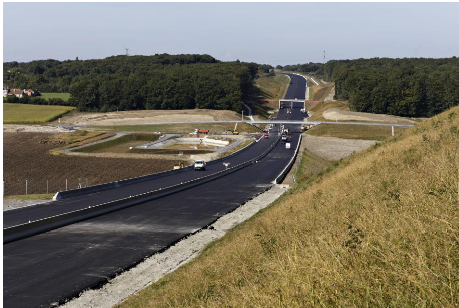
Figure 50 : A719 Gannat-Vichy : travaux de construction (photo APRR)
