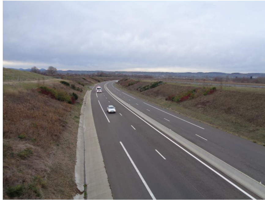
Figure 5 : A719 - section courante (photo setec)
