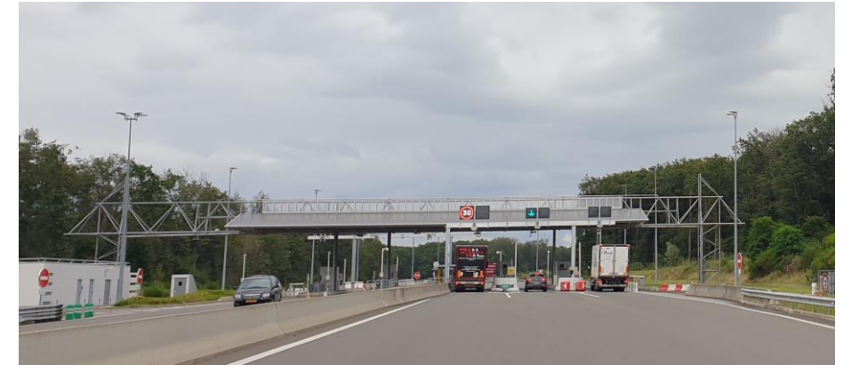
Figure 6 : A719 - barrière de péage pleine voie (BPV) de Vichy (photo A7 Conseil)
