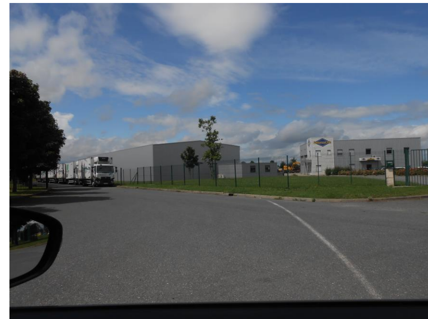
Figure 69 : Gannat – Zone d'activités des Prés Liats près du diffuseur n°13 de l'A719 (photo A7 Conseil)
