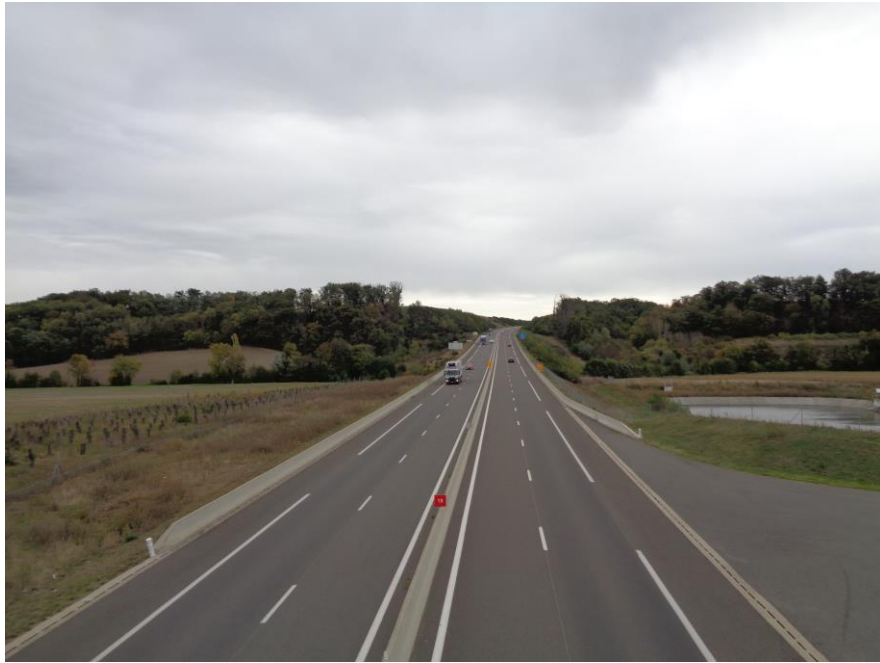
Figure 4 : A719 - section courante (photo setec)
