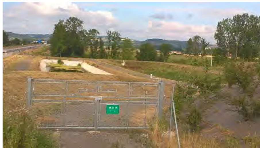
Bassin multifonction BR110 bi-corps (© Egis / A.S. Chaudat, 2016)
