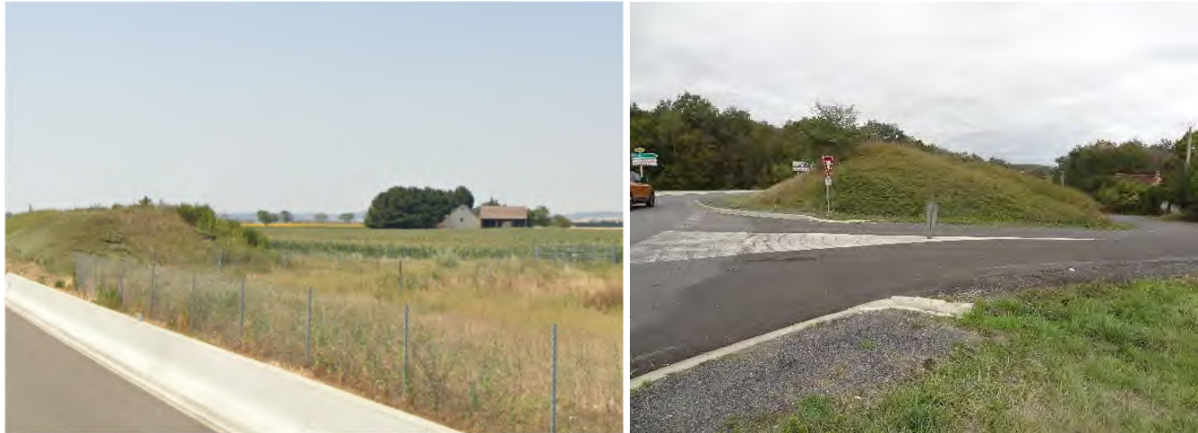
A gauche : Merlon acoustique réalisé au droit de la Ferme Banelle (© Egis / B. Desille, 2020) A droite : Merlon réalisé au droit de Maison Blanche (© Egis / D. Ferreira, 2020)
