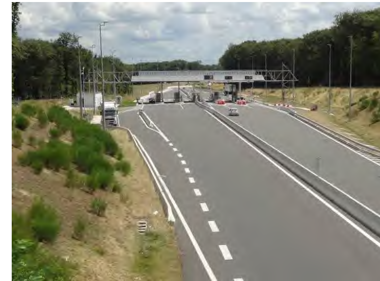
Barrière de péage (© Egis / D. Ferreira, 2016)
