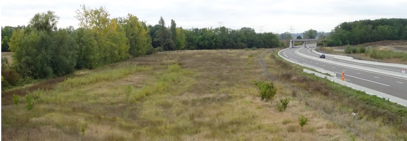
Zone humide créée sur un délaissé entre l'A719 et le Châlon (© Egis / B. Desille, 2020)
