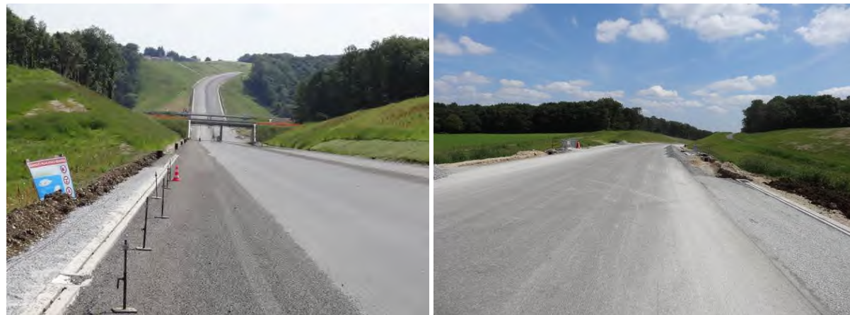
Déblais engazonnés en cours de travaux, juin 2014 (© Egis / D. Ferreira, 2016)
