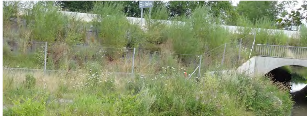
Végétalisation des talus à proximité de la Toulaine en continuité avec les cimes existantes (© Egis / D.Ferreira, 2016)
