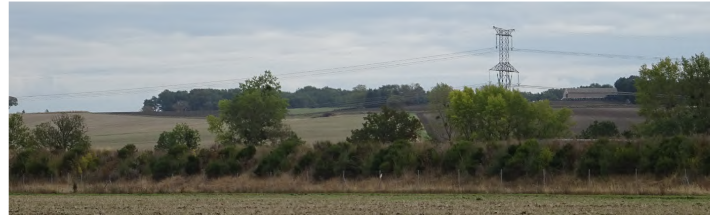
Merlon acoustique végétalisé au niveau du lieu-dit « Banelle » (© Egis / B. Desille, 2020)
