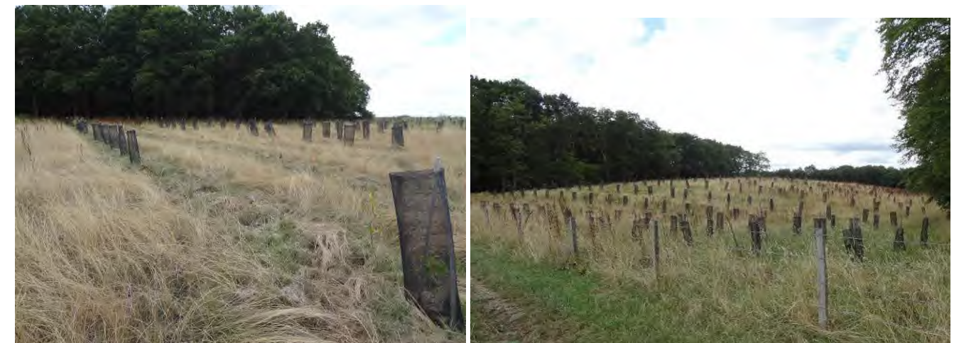
A gauche : plantations sur la zone des Courtieux, à droite sur un dépôt définitif en continuité du Bois de Charmeil dans le vallon de la Goutte Jeanton (Egis / D. Ferreira, 2016)
