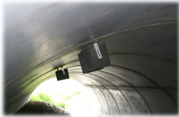
Nichoirs artificiels installés dans les ouvrages OH160 et OH162 (© Biotope / S. Vigant, 2015)
