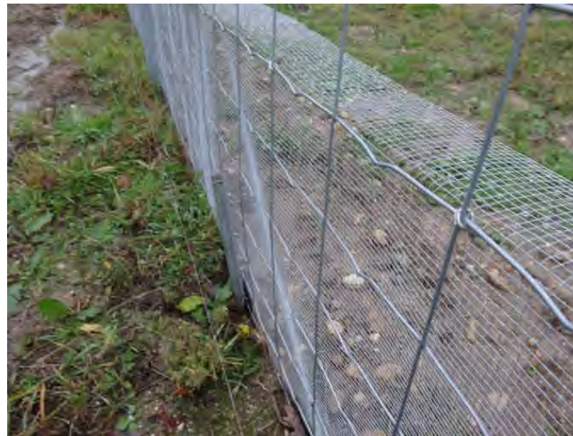
Clôture grande faune doublée en pied d'une clôture amphibiens avec bavolet, exemple d'implantation en tête d'ouvrage sur l'OH212 – Goutte Jeanton (© Egis / D. Ferreira, 2016)
