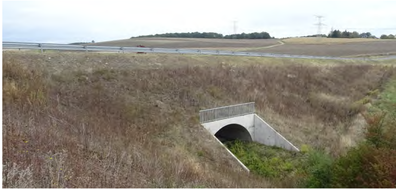
Intégration paysagère des talus de remblais (© Egis / B. Desille, 2020)
