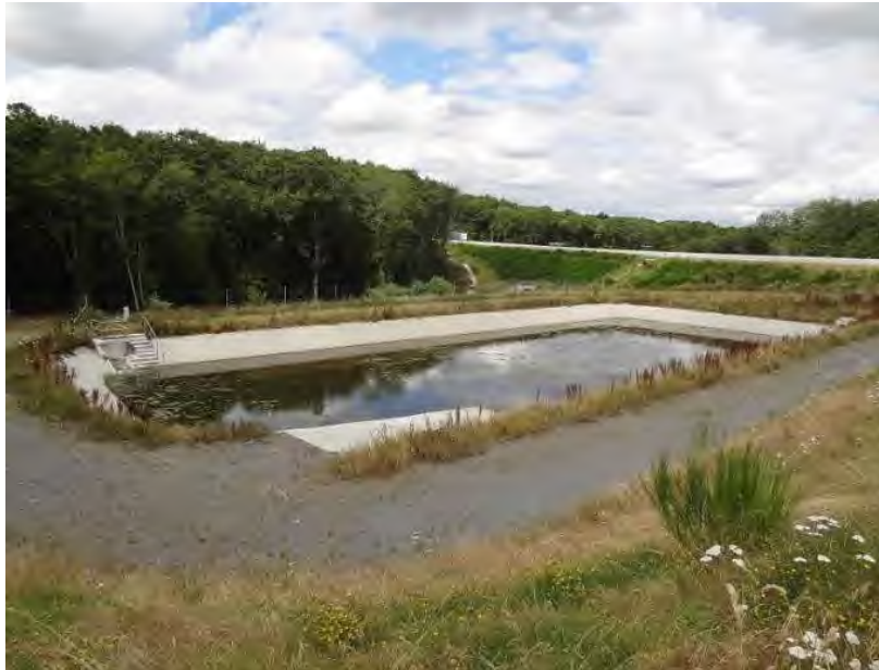
Bassin multifonction BR222 mono-corps (© Egis / A.S. Chaudat, 2016)
