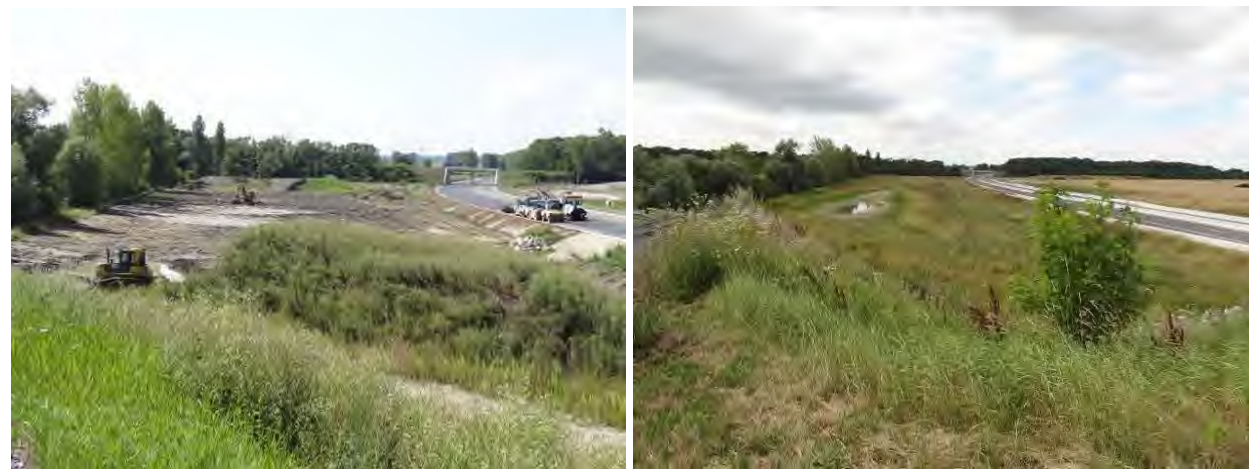
Zone humide du Châlon pendant et après les travaux en 2014 et 2016 (© Egis / D. Ferreira)
