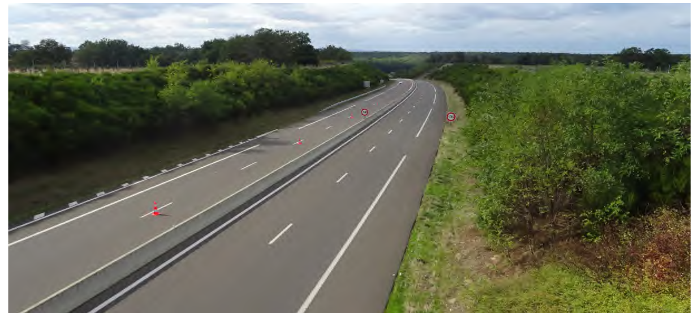
Intégration paysagère des talus de déblais (© Egis / B. Desille, 2020)
