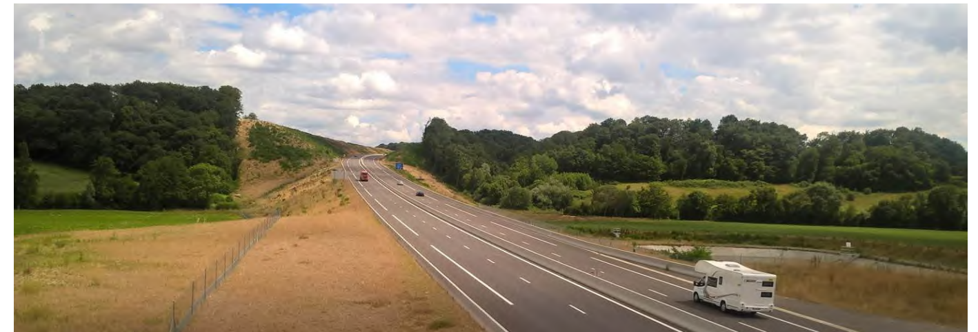
Vue depuis la RD279 sur le vallon du Béron et le Bois des Gouttes (© Egis / D. Ferreira, 2016)
