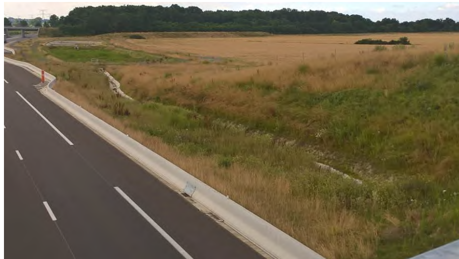
Intégration paysagère du bassin BR196 dans un milieu ouvert (© Egis / D. Ferreira, 2016)
