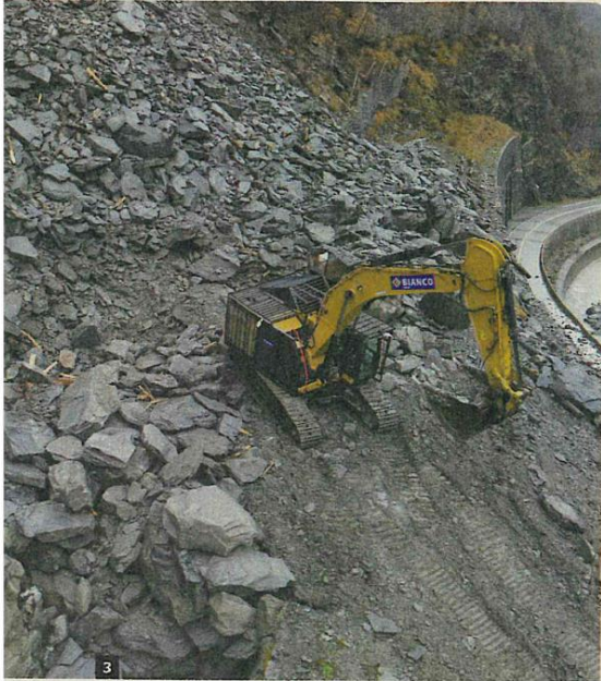
3 - L'éboulement a coupé la voie ferrée et deux routes. La circulation a pu être rétablie sur une partie de l'A43 grâce à la pose de 60 containers par NGE Fondations. 2 - Le bungalow dans lequel opèrent les conducteurs de Bianco est situé à 150 m de la zone dangereuse. 3 - Les pelles sont protégées par des cages pour éviter qu'elles soient endommagées par de nouvelles chutes de pierres. 4 - Cinq engins fonctionnent sept jours sur sept avec deux équipes par jour. 5 - Initialement prévu pour des vues détaillées, le drone s'est révélé indispensable pour disposer d'une image d'ensemble.
