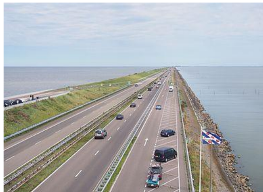
Extrémité occidentale de l'Afsluitdijk
