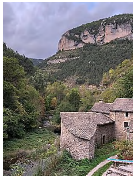
Couvertures en lauzes sur bâti ancien à Hures-la-Parade - photo OS - octobre 2023
