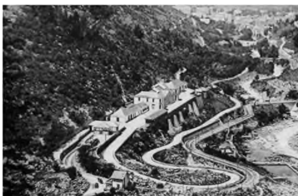
Le chantier du Limaçon en 1898 et la plateforme, ci-dessus - Les infrastructures du tramway à la Raillière en 1900, ci-dessous - Collection Mengelle
