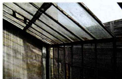
Cour avant curetage
