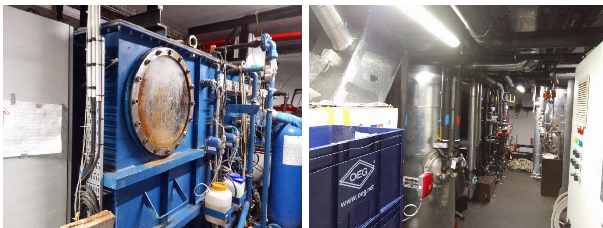
12. Dans les soutes du refuge (éléments du système EVAC) - Photos ThB, septembre 2023
