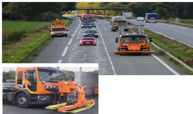
Figure 10 - Système de pose des bandes d'alerte sonore (source : DMR)
