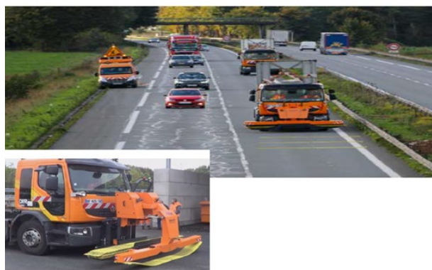
Figure 36 - Système de pose des bandes d'alerte sonore (source : DMR)
