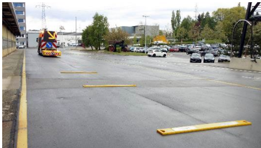
Figure 13 - Fourgon équipé d'amortisseur de choc et utilisé pour la pose de bandes sonores d'avertissement (source: SIERA, Suisse)
