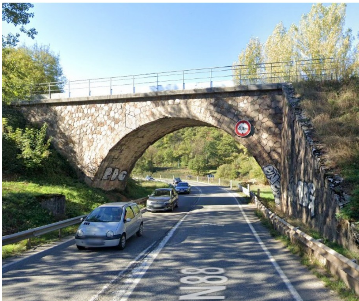
Figure 3 : Vue du passage sous le pont-rail de Salabru dans le sens sud-nord Source : Étude géométrique de circulation des véhicules agricoles, DIR Sud-ouest, 7 août 2020
