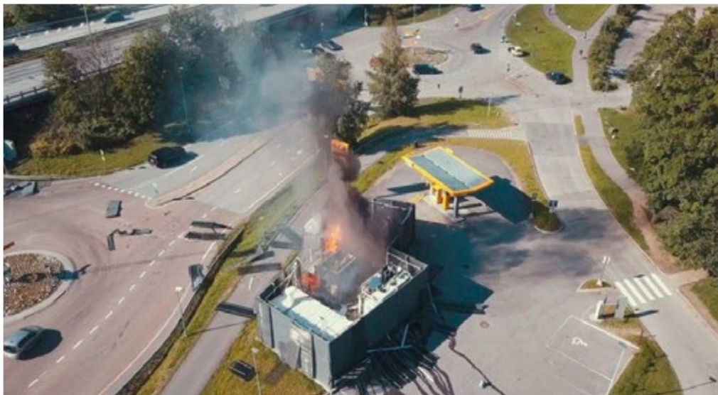
Figure 9 : Incendie dans une station-service à hydrogène à Kjørbo en Norvège en 2019 86 .
