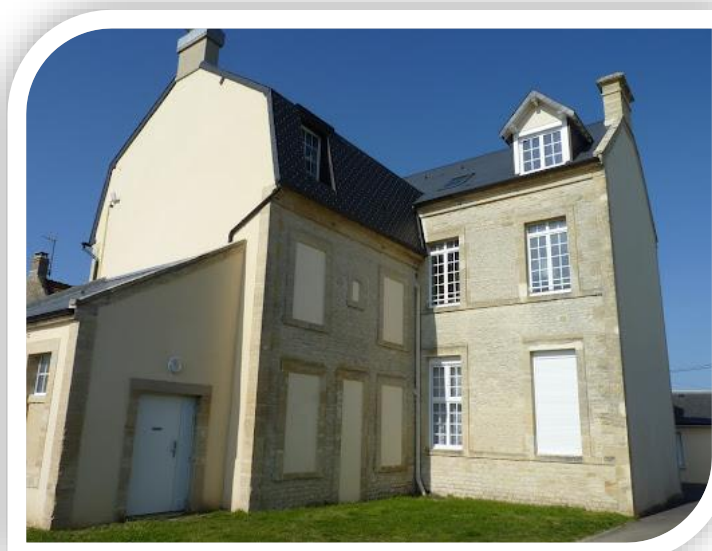
Image d'une antenne de FJT (source URHAJ Normandie)
