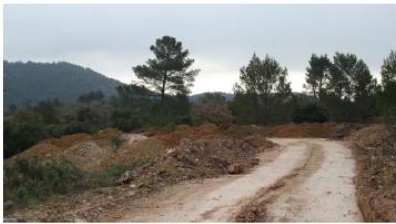
47 - Dépôts de matériaux
