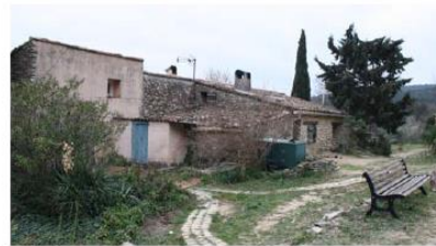
48 - Ferme sur les contreforts
