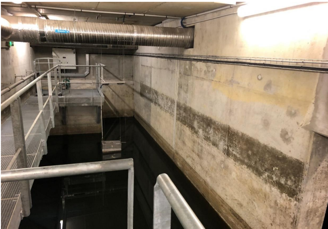
Figure 6 Bassin de rétention (photo mission)
