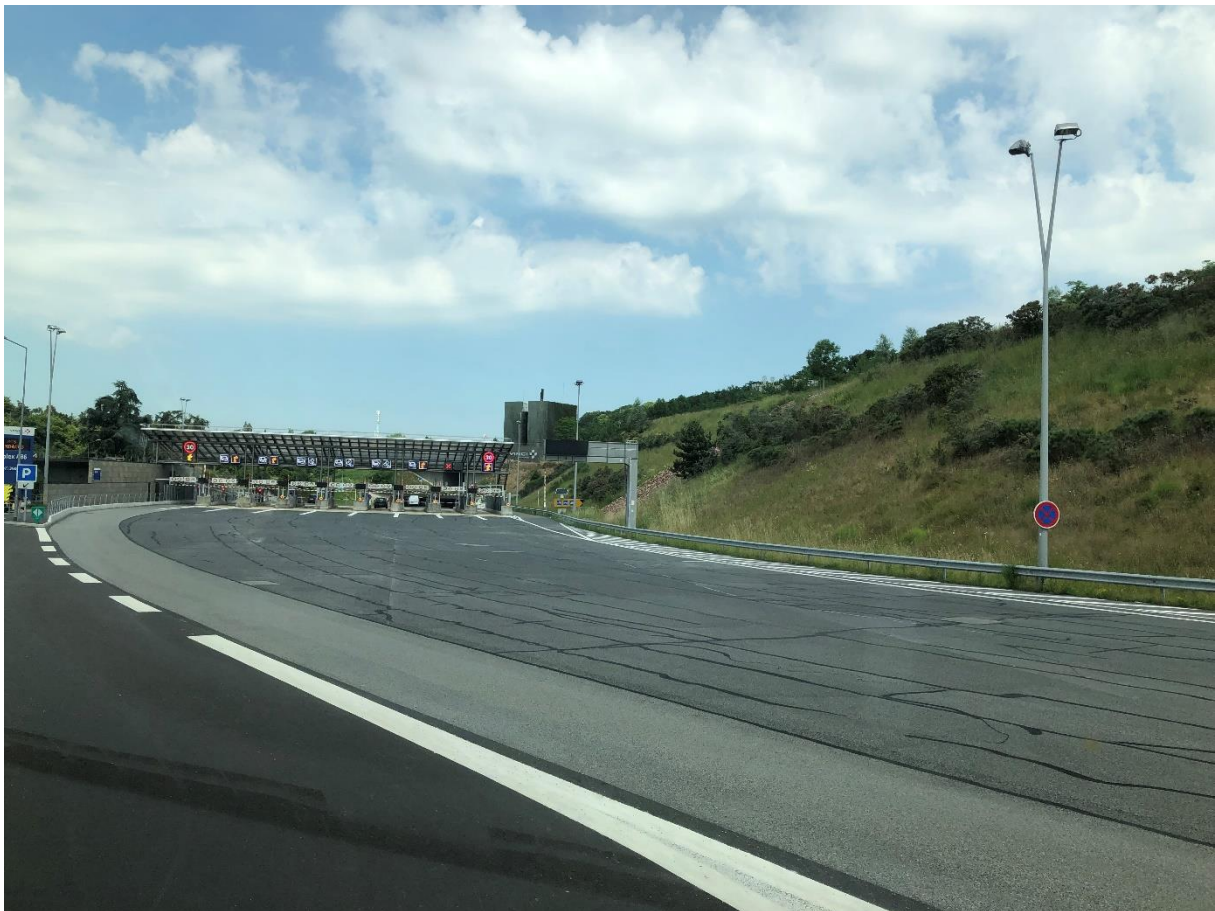
Figure 2 barrière de péage de Vélizy- Pont Colbert (photo mission)
