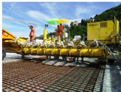
Viaduc de Chillon: Intervention BFUP armé (2014/15)
