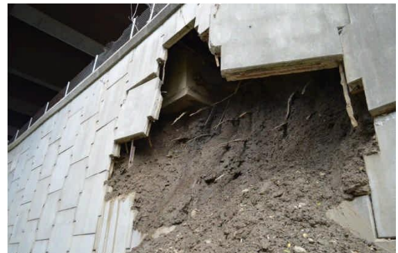
Figure 10.: photos de l'incident survenu en octobre 2016- bretelle du Saw Mill River. Parkway (Etat de New York) et photo de la réparation au moyen d'un clouage
