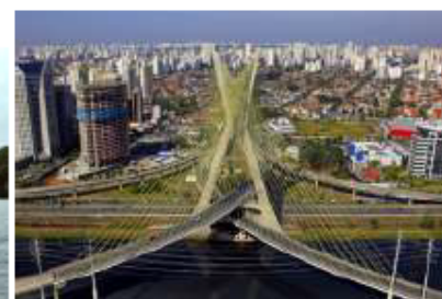
Pont Rio Pinheiros São Paulo
