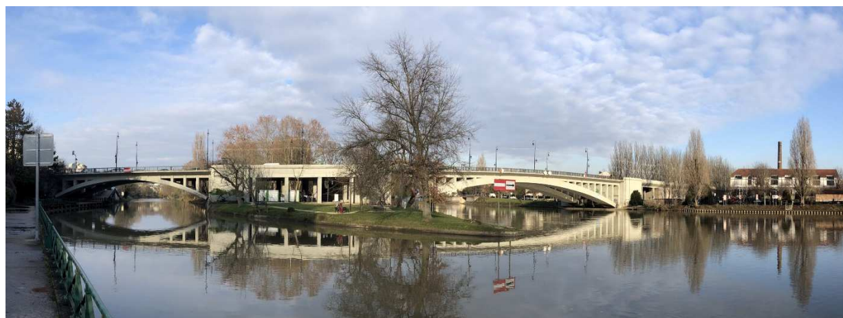
Vue du franchissement de l'île Fanac depuis le sud-ouest (parcelle D 19) - Ph OS - janvier 2021
