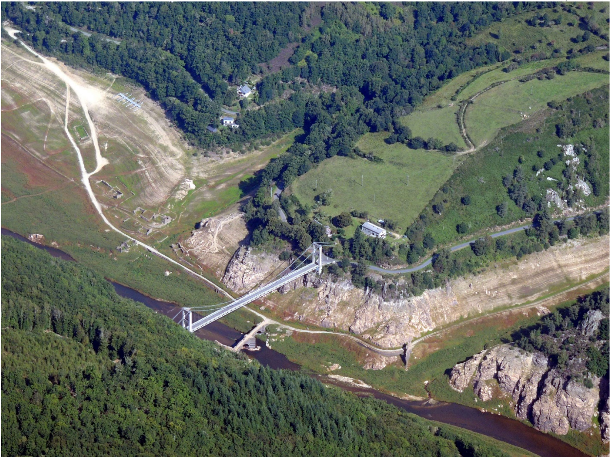
Les vestiges du fond du lac du barrage de Lanau en 2015 lors du vidage du barrage – ph.internet
