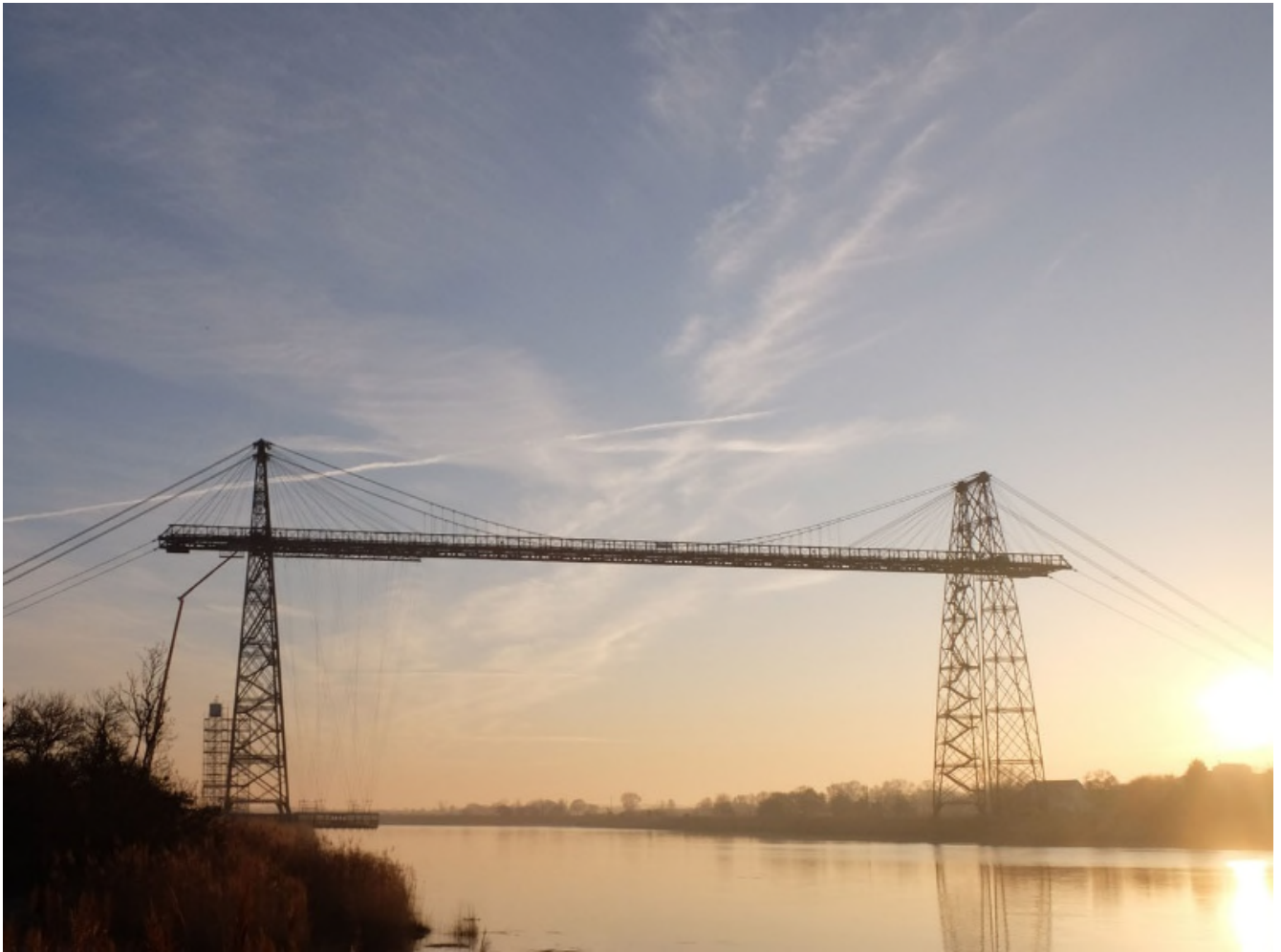
Pont transbordeur du Martrou - Ph. DM
