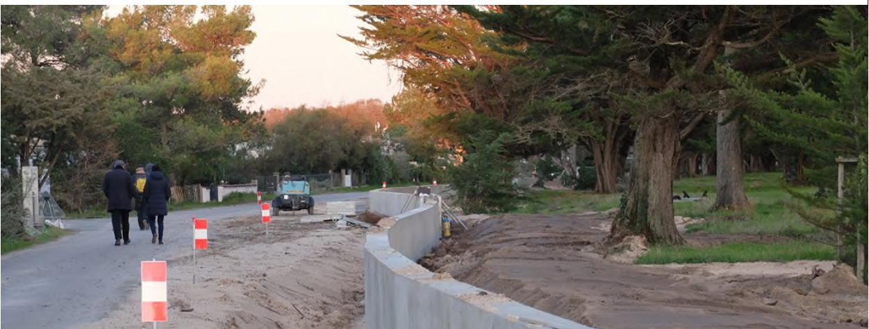
Construction d'ouvrages de protection submersion marine sur l'Île d'Aix - Ph. DM
