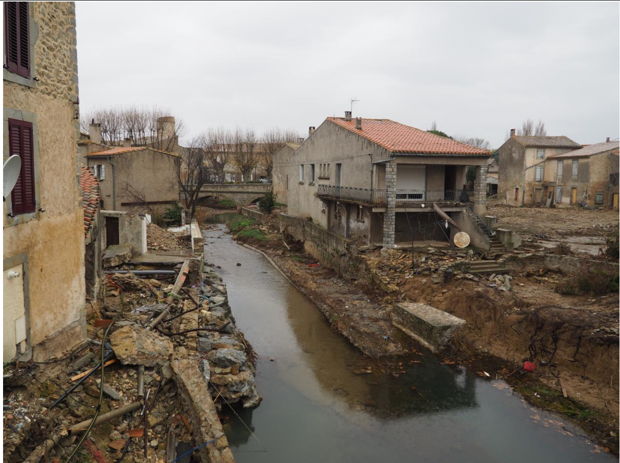
Villegailhenc – octobre 2018, photo CGEDD 10/2018
