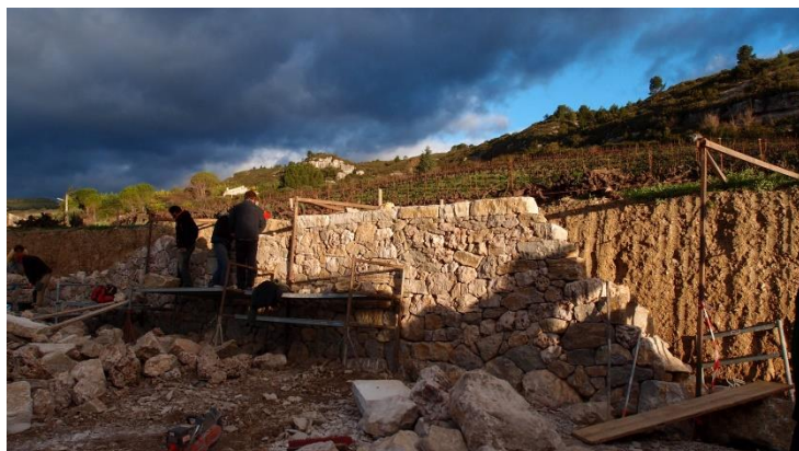
Chantier du mur en pierre sèche – La Caunette – photo JLC
