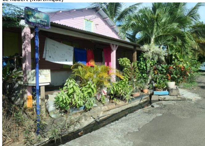
3-en-1 : Arrivée d'eau potable, évacuation eaux usées, stagnation d'eau croupie
