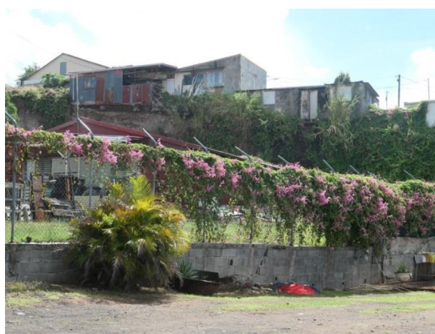
effondrement des maisons, Basse-Terre (Guadeloupe)
