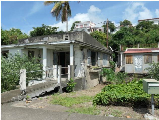
Cette maison située au niveau de la mer (zone verte hachurée sur le plan d'aménagement) sera démolie.
