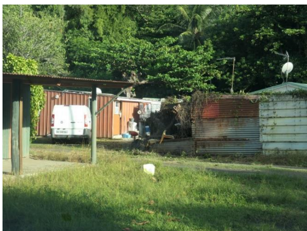
Constructions de tôle et de planches posées sans cohérence.
