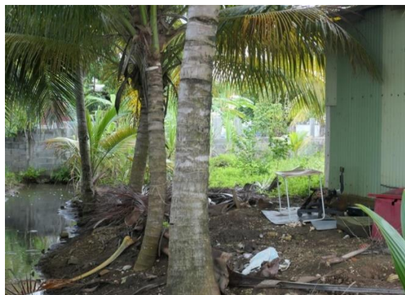
Remblai au bord d'une rivière Capesterre-Belle-Eau (Guadeloupe)
