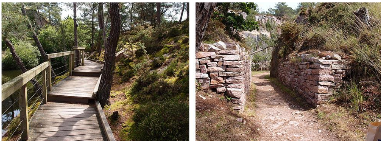
Le sentier d'interprétation d'Erquy, aménagé par le département – Photos JLC à g. passerelle en bois, œuvre d'un charpentier de la région – à d. murets de pierre sèche par un chantier d'insertion
