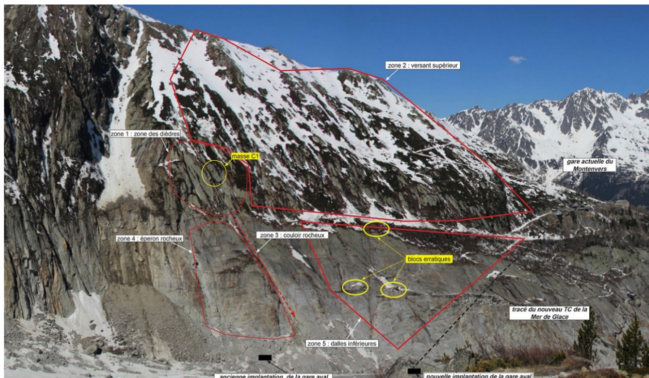
13. Étude géotechnique des implantations de la gare aval : diagnostic des risques de chutes de blocs (SGAE ingénierie, mars 2020).
