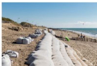
Big bags en géotextile à Gouville-sur-Mer (29/08/16) © Thierry Houyel
