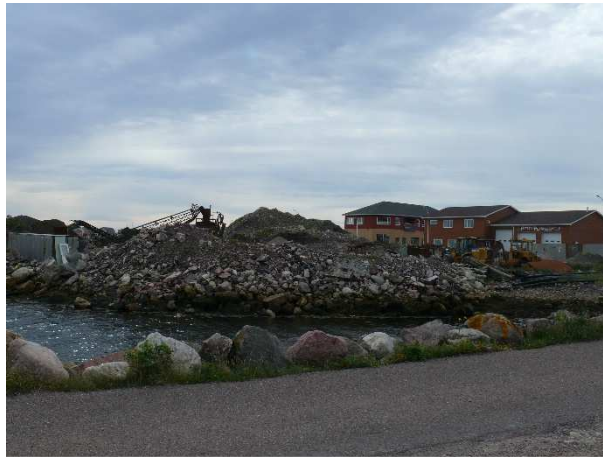
Illustration n° 20 : Dépôt Allen-Mabé sur AOT – Terre-Plein du Sud-Barachois
