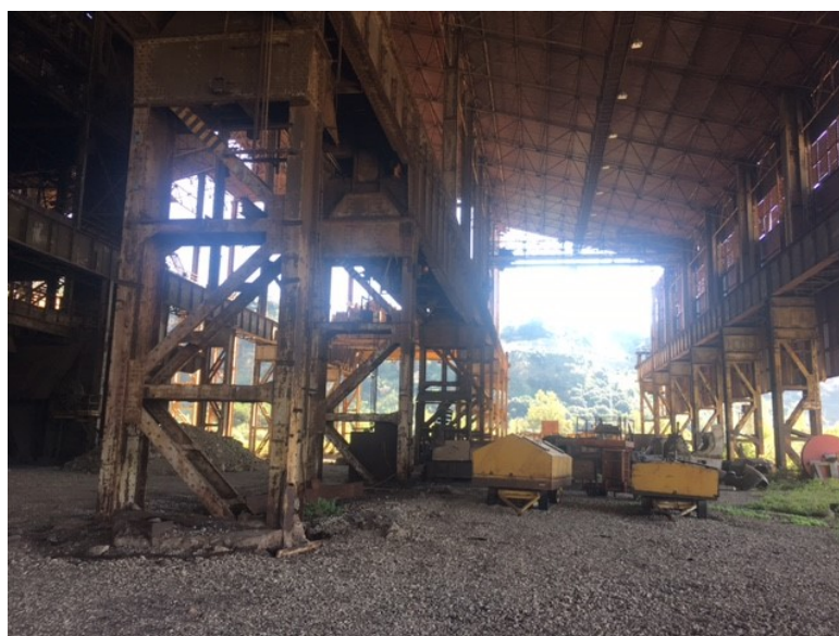
Vue de l'intérieur d'une structure industrielle de la friche de Bagnoli, qui sera conservée pour l'installation de commerces et de services.
