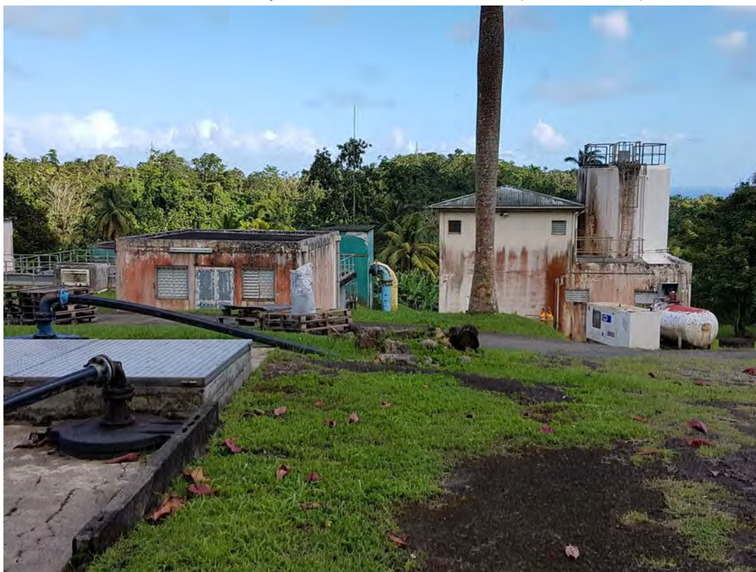
Photo n° 6 : usine de potabilisation de Belle-Eau-Cadeau (source : mission)
