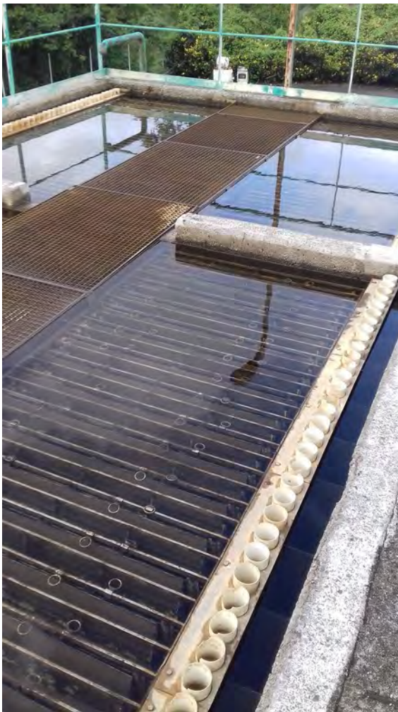
Photo n° 7 : usine de potabilisation de Moustique : décanteur lamellaire et filtres à sables (source : mission)
