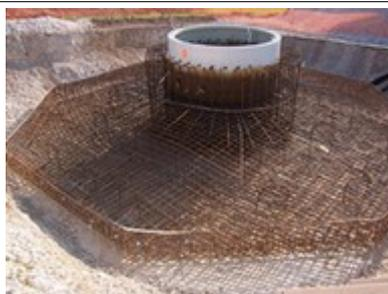
Photo n°5 : éolienne en cours de construction : la fondation s'arrête à un mètre en dessous du niveau du sol et est ensuite recouverte de terre.
