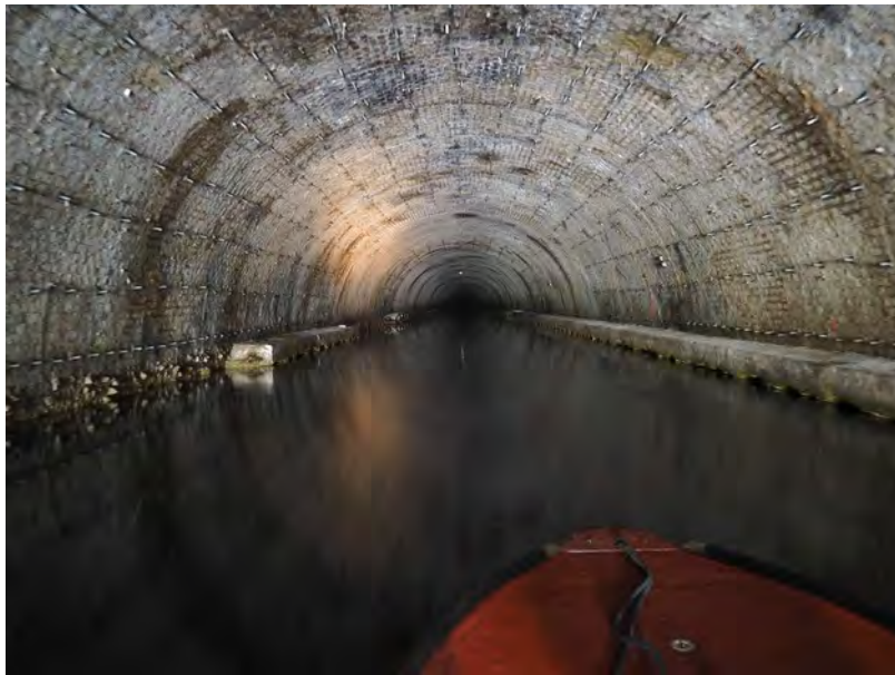
Le tunnel du Rove, tronçon sud (photo mission)
