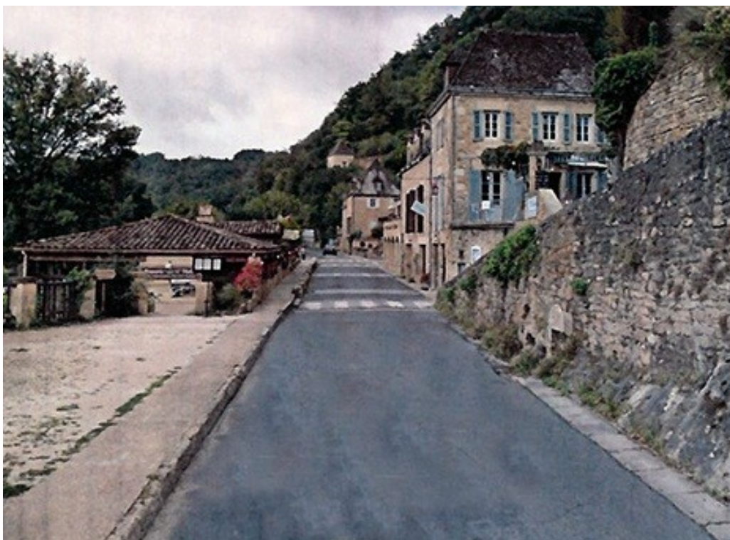
À gauche côté Dordogne, les bâtiments de restauration et l'espace routier contraint, avant travaux, vue vers l'ouest. Source Google street view
