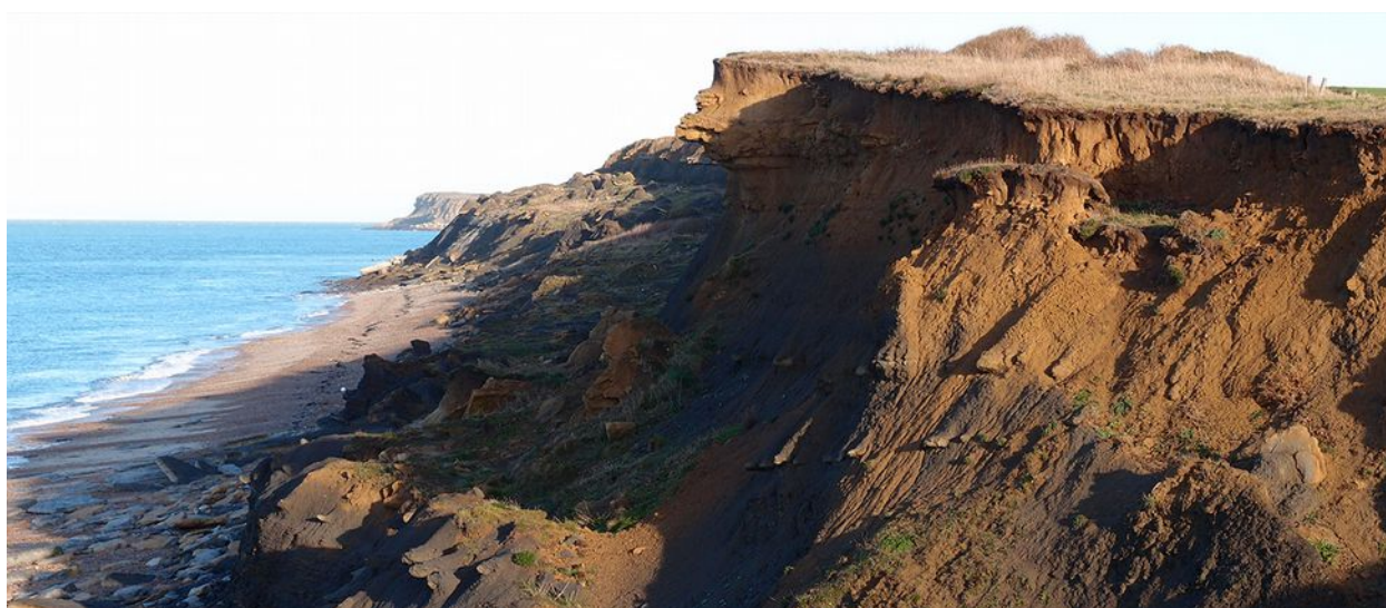
L'érosion de la côte est due à de multiples facteurs : ici, glissement de terrain au Noirda – Audresselles (PhotoJLC)
