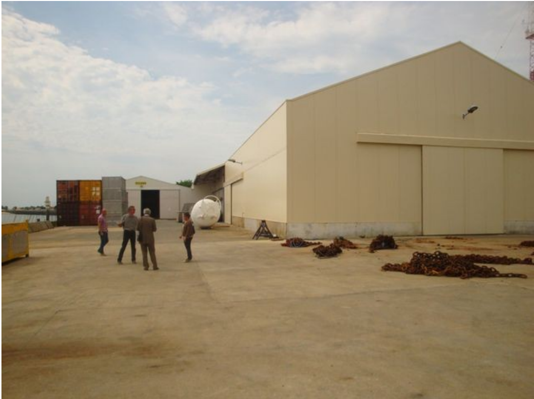
Centre de stockage du Verdon : Le hangar est voisin de celui des Phares et Balises. Il dispose d'un quai pour l'embarquement des chaînes et des ancrages de corps-morts
