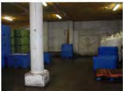
Ancienne salle avant les travaux
