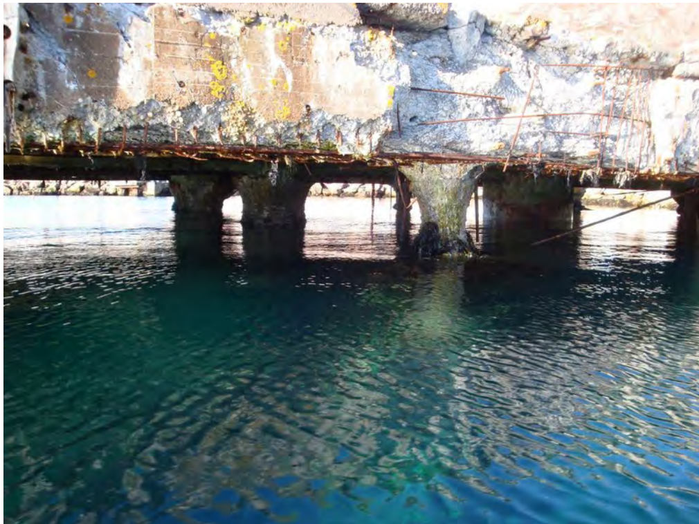
Figure 2 : Le quai Guérin ne peut être conservé en l'état, il mérite d'être remplacé par un pieu d'amarrage fixe (photo : A. Pichon).
