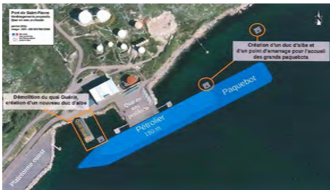
Figure 3 : Le projet d'amélioration de l'accueil des navires de croisière par création de ducs d'Albe d'amarrage (photo : DTAM).
