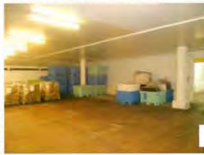
Salle de traitement après les travaux et avant aménagement
