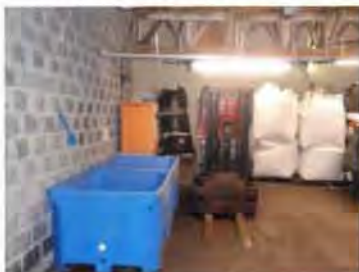
Ancienne salle avant les travaux
