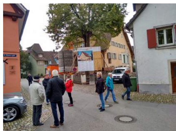
15. L'hôpital en cours de rénovation-transformation profonde
