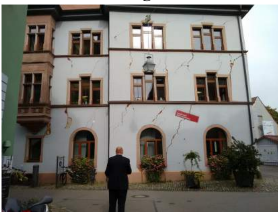
14. L'hôtel de ville très fortement endommagé
