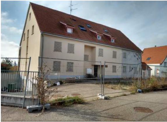
1. Le bâtiment collectif sinistré (nombreuses fissures), au fond l'habitation voisine
