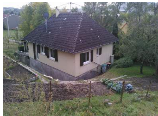
13. Une habitation récente « protégée » des déplacements horizontaux par un fossé
