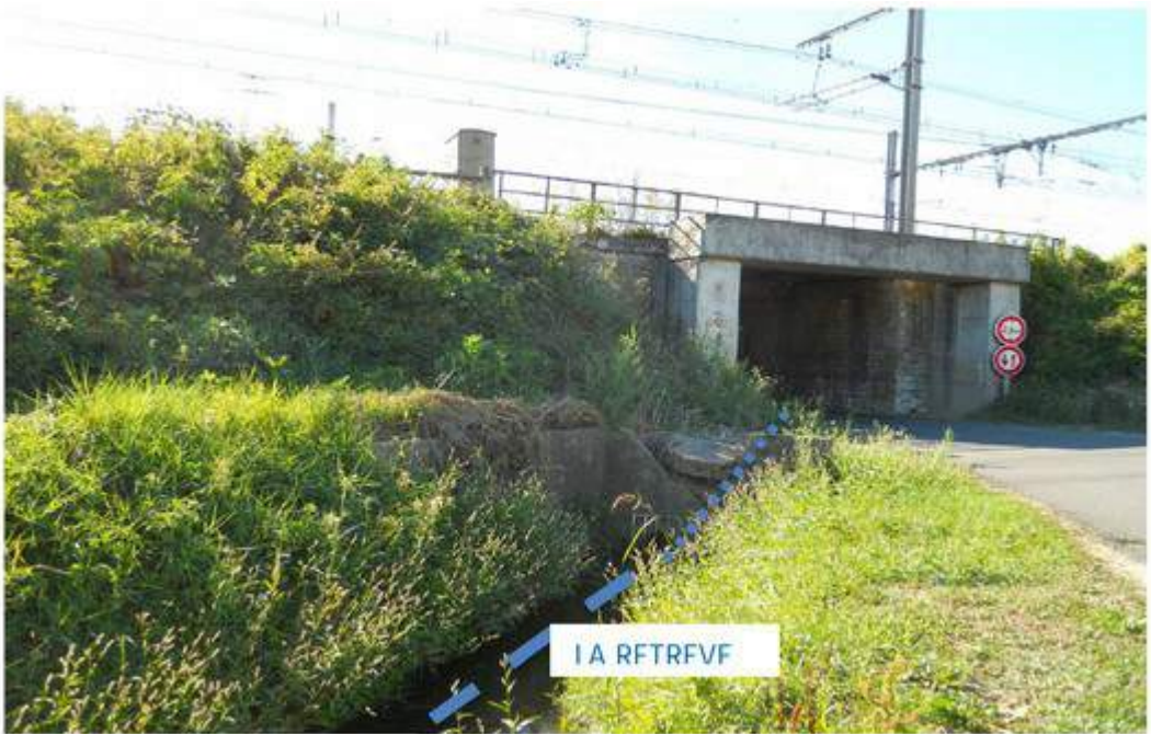
Figure n°8 – Ouvrage de la voie ferrée à l'amont – Source COFIROUTE
