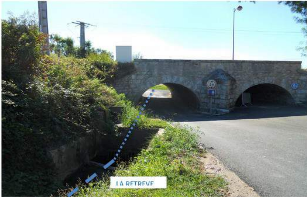
Figure n°7 – Ouvrage RD 2020 à l'amont – Source COFIROUTE
