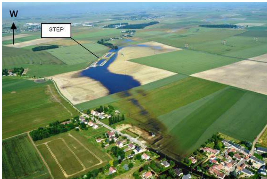
Figure 13 – Station d'épuration de Gidy le 9 juin, Source BRGM annotation BRGM
