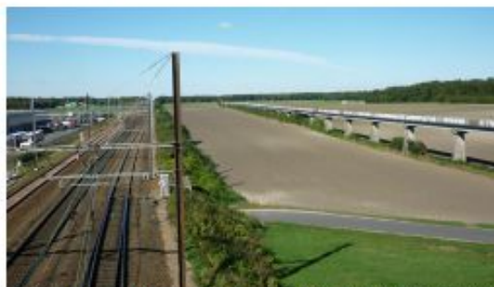
Les usagers du train sont directement confrontés à l'ouvrage, qu'ils peuvent suivre quasiment de bout en bout.
