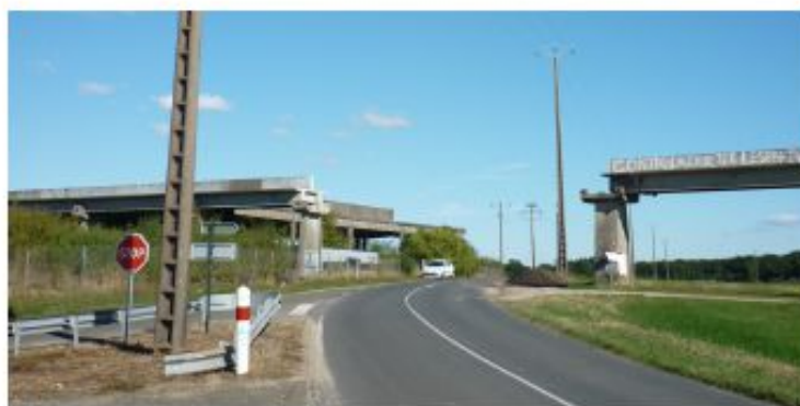
L'intervention curative suite à la rupture des câbles de tension a rompu le lien du viaduc avec le station. Si des opérations curatives ou préventives sont à envisager, il faut qu'elles puissent s'opérer sur des sections courtes pour limiter une atomisation trop grande de l'ouvrage.
