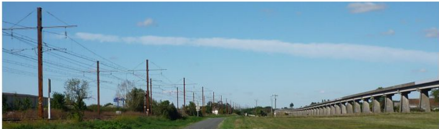
Le viaduc entretient une singulière complicité avec le réseau ferré qui l'accompagne de bout en bout et le donne à voir en mode traveling depuis les wigons.
