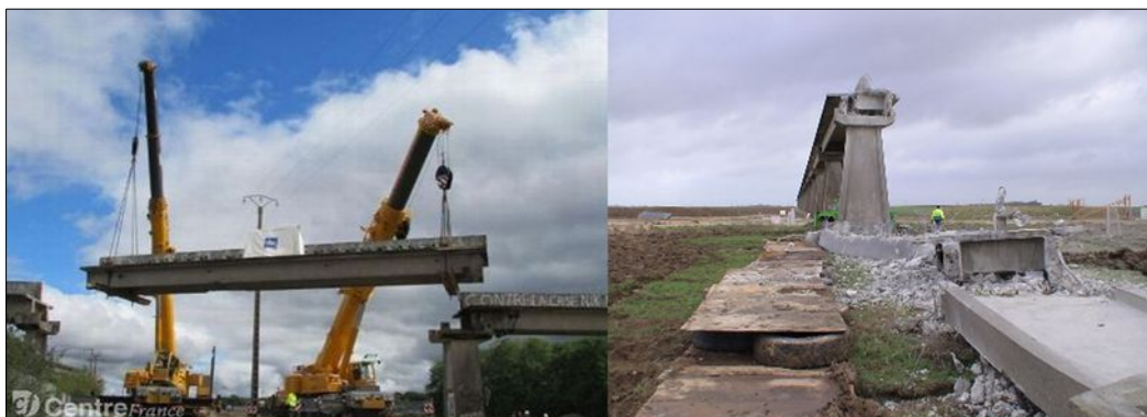
Illustrations 21-22 : dépose travée à Chevilly (21) – CEREMA – démolition au niveau A19 (22) – Trapil
