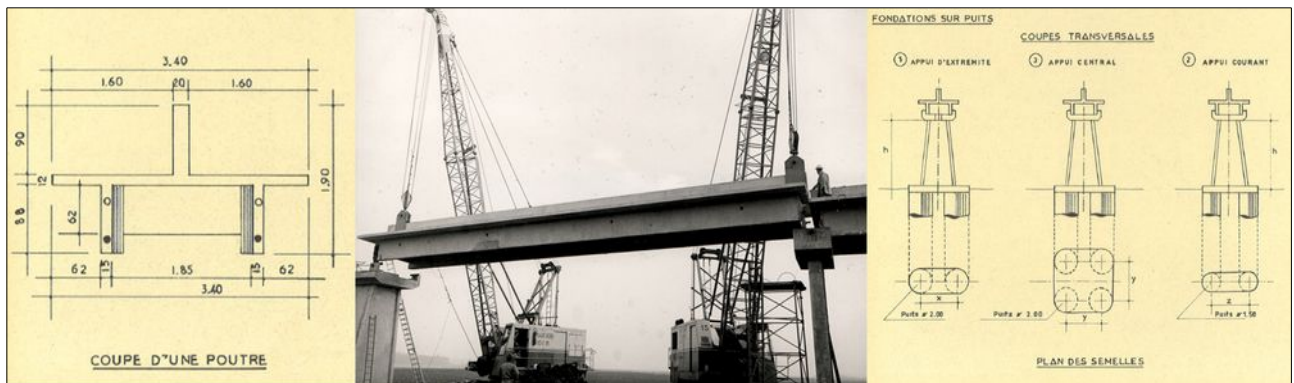
Illustrations 8-9-10 : coupe du monorail et fondations sur puits (8-10) – pose d'un élément (9) – CEREMA.
