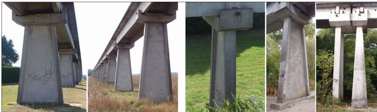
Illustrations 25 à 29 : piles de hauteur variable (25-26) et d'épaisseur variable (27 à 29) – photos JLC et JT
