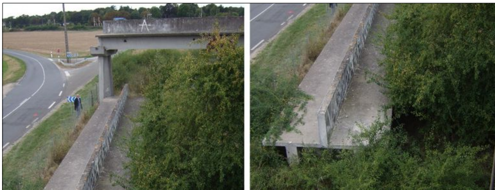
Illustrations 72-73 : la poutre déposée au sol à Chevilly– photos JT
