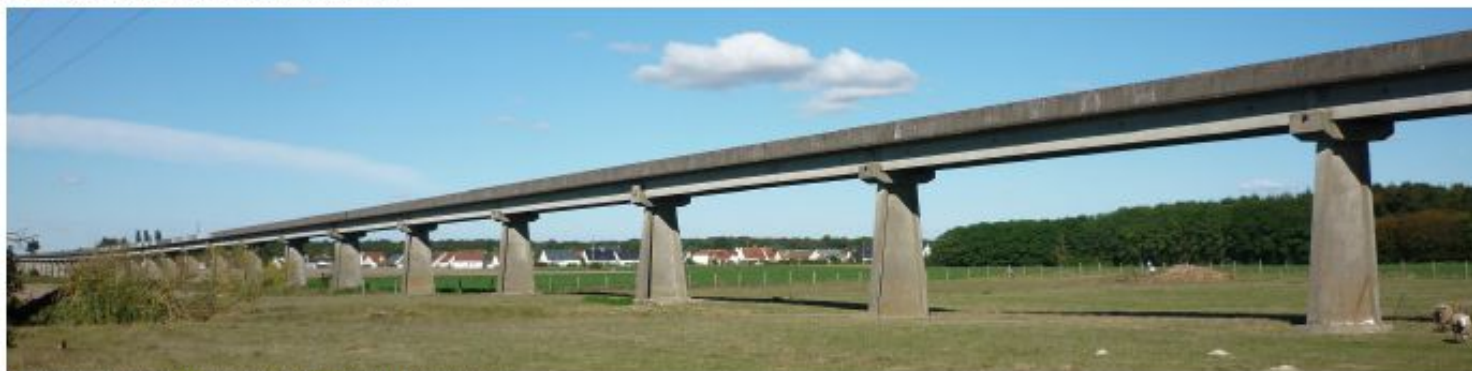
Les extensions urbaines récentes se sont dans la plupart des cas tenues à distance du viaduc.
