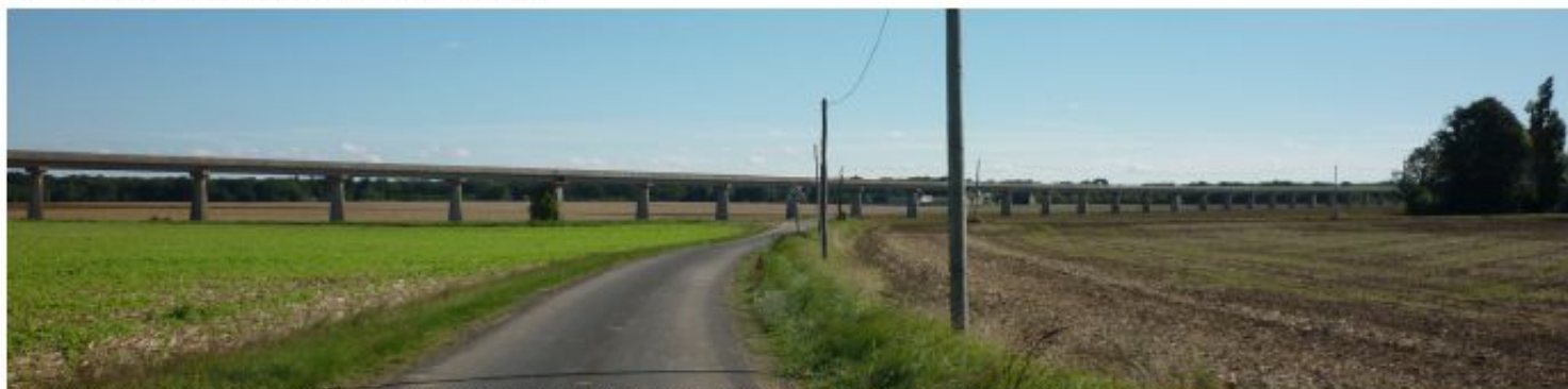
Le réseau de routes et chemins d'entretien rendent finalement très dynamique l'ouvrage dans son paysage. On le voit de loin, de près, on le croise, on le longe, il apparaît, il disparaît.
