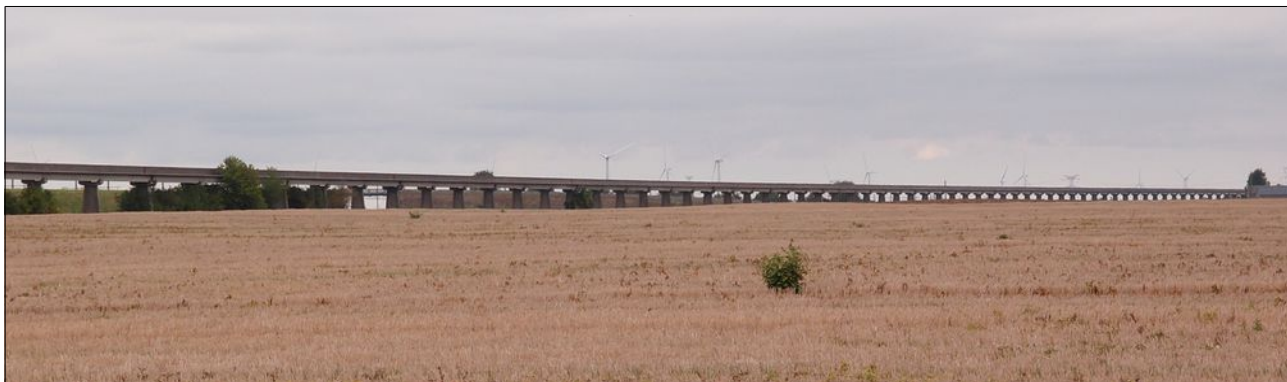
Illustration 2 : l'ouvrage dans la Beauce – photo JLC
