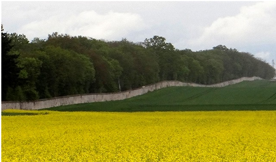
Le mur d'enceinte du grand parc – source DREAL Centre Val-de-Loire
