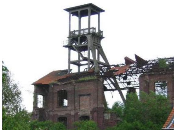
Chevalement de la fosse 2 à Anhiers
