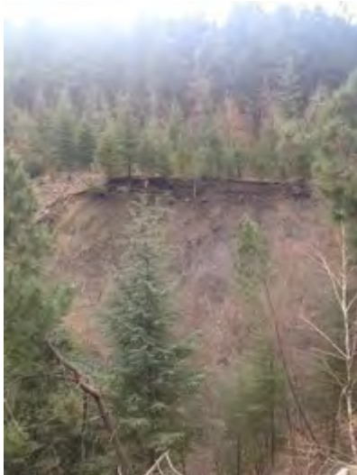
Érosion importante du terril surplombant le ruisseau de Barbezieu (ravine torrentielle)
