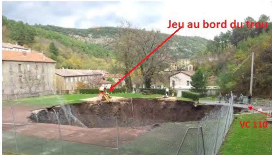
Effondrement de Rochessadoule en novembre 2012 Source : mairie de Robiac-Rochessadoule
