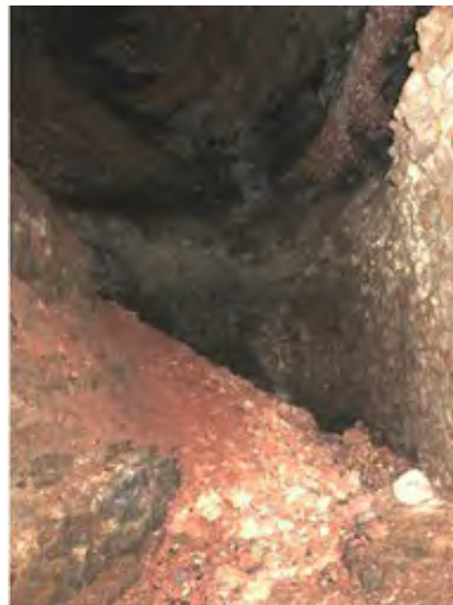
Cloche d'effondrement de la voûte, avec amorce de fontis (La vieille Valette à Robiac)
