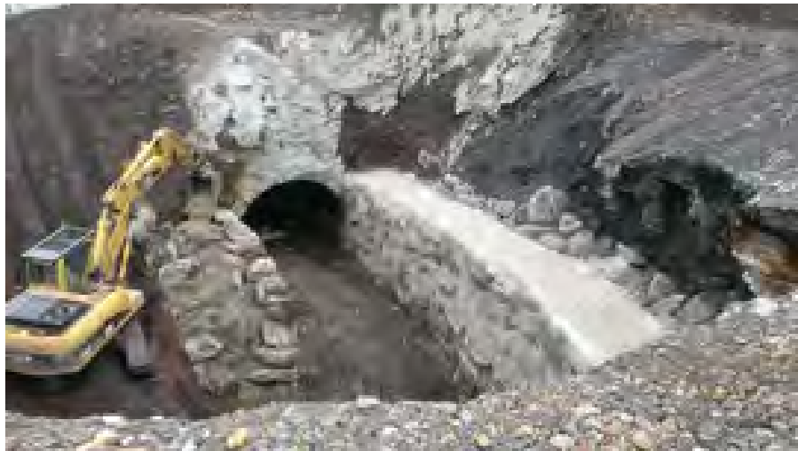
Chantier de reconstruction de la partie effondrée
