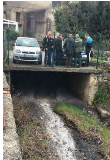
Busage du ruisseau sous le village de Trescol Photo mission ci-dessus et ci-dessous
