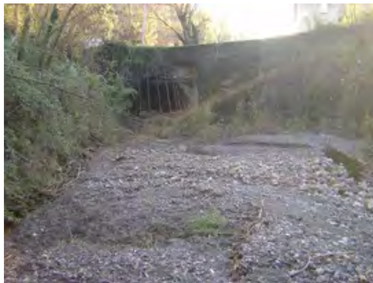
Entrée du tunnel du ruisseau « Sans nom »
