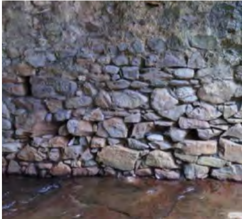
Creusement des joints par départ progressif du mortier
