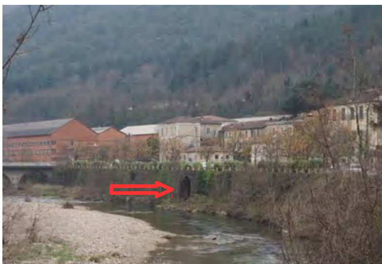
Bessège : ruisseau couvert en zone urbanisée (photo mission)
