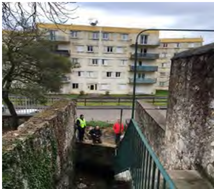
Ruisseau couvert passant sous un immeuble (Alès) (photo mission).
