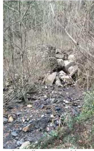
Ouvrages hors d'usage : gabions explosés, bassin de rétention des sédiments saturé...
