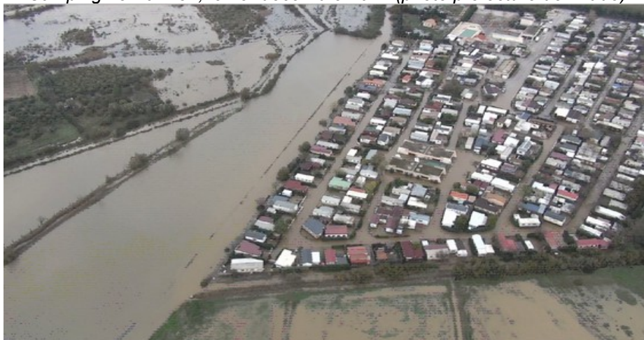
Camping Le Pavillon, le 1er décembre 2014 (photo préfecture de l'Aude)
