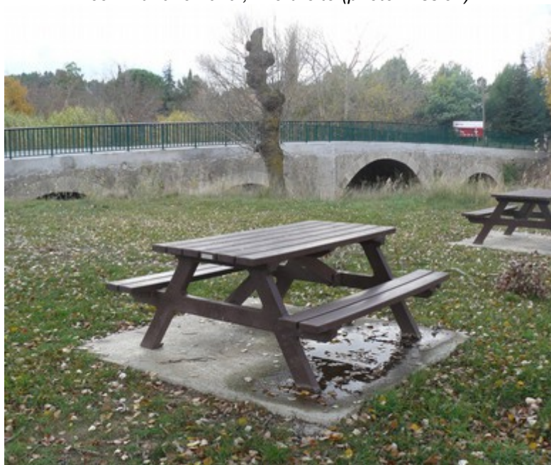
Pont sur le Barrou, à Durban-Corbières : vue du terrain communal en aval, rive droite (photo mission)
