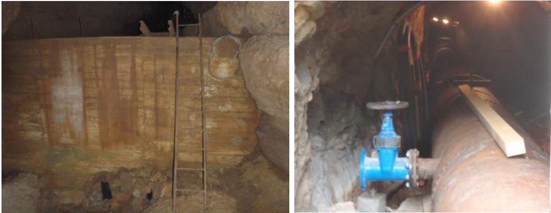
Photos 1 et 2 ; barrage souterrain et conduite dans la falaise, cliché mission
