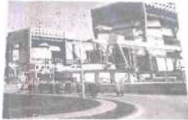
La deuxième tranche de la centrale de Saint-Laurent-des-Eaux (A 4 filiales graphite-gaz) a été mise à l'arrêt jeudi, en fin de soirée, à la suite d'un accident sérieux survenu sur le réacteur.
