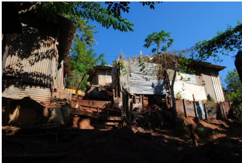
Habitations situées sur la partie haute du bidonville de Kawéni à Mamoudzou (risque de glissement de terrain)
