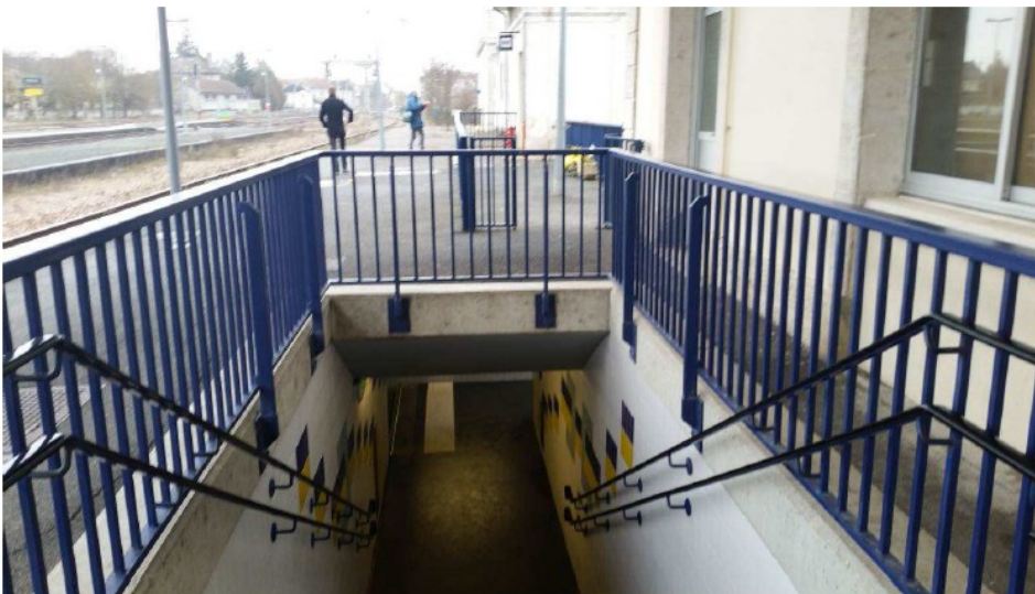
Passage souterrain de la gare
