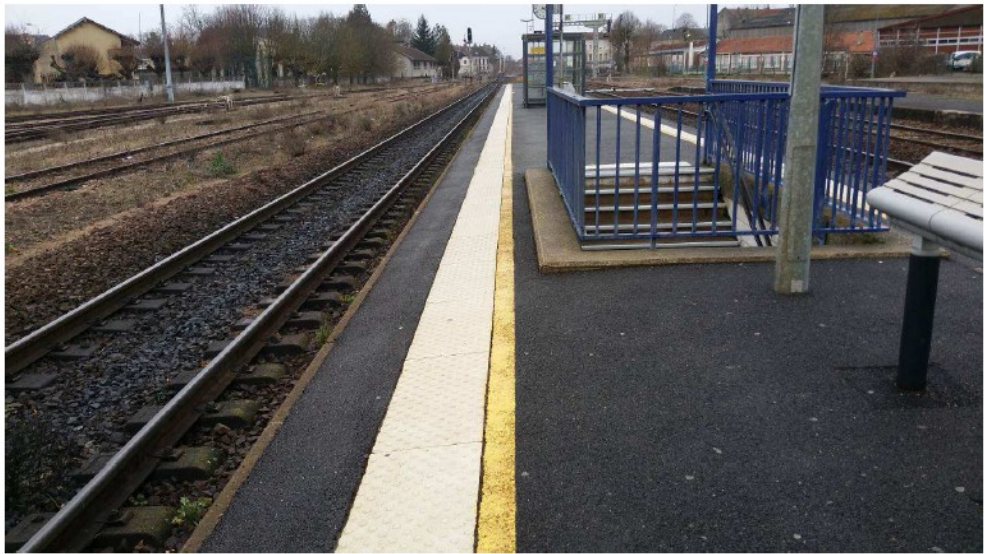
Quai n°3 de la gare de Romilly-Sur-Seine
