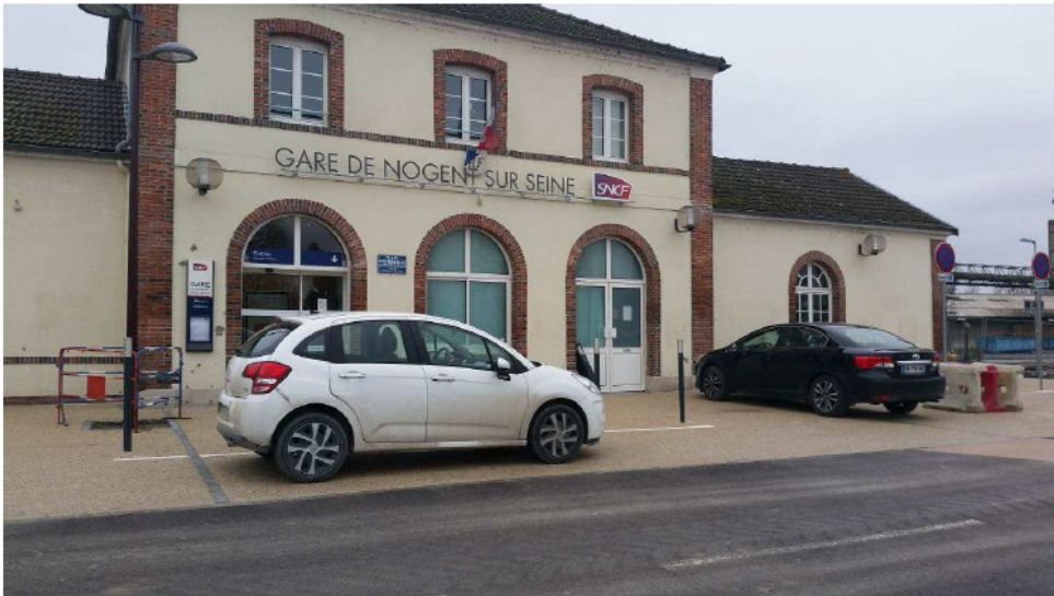
Bâtiment Voyageurs de la gare
