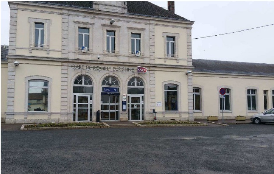
Bâtiment Voyageurs de la gare
