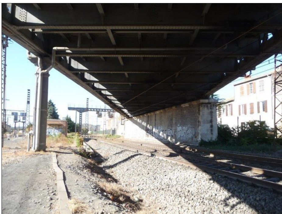
A gauche sur la photo, un fût de la pile de l'ouvrage concerné
