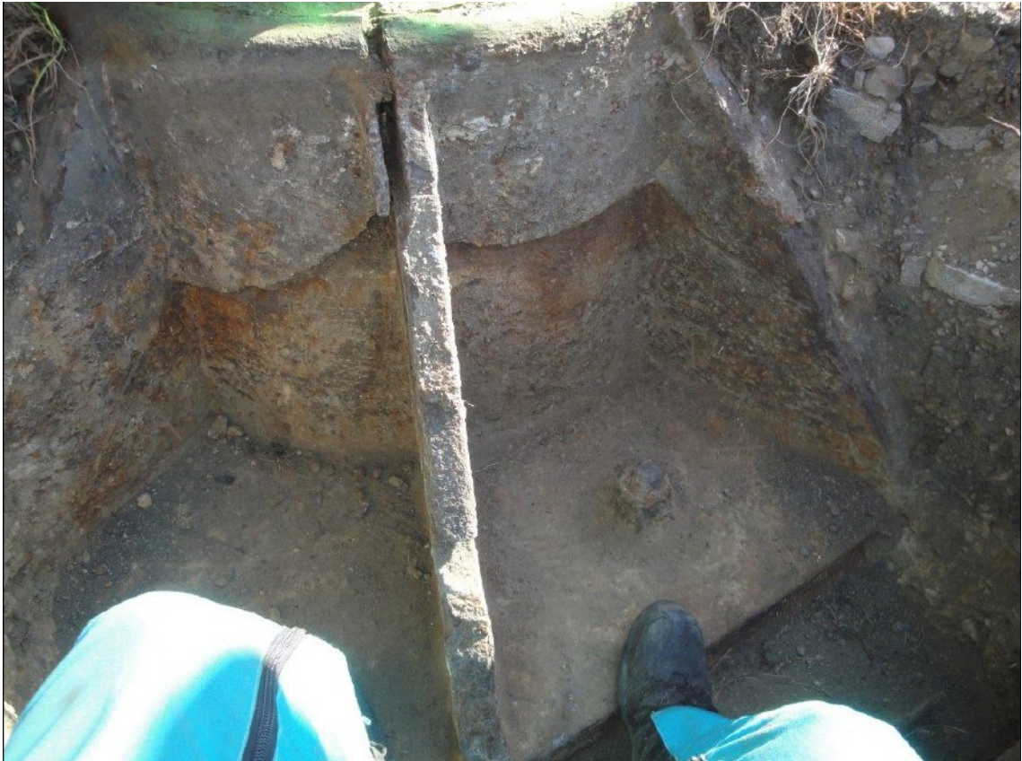
Détail du pied du fût de pile
