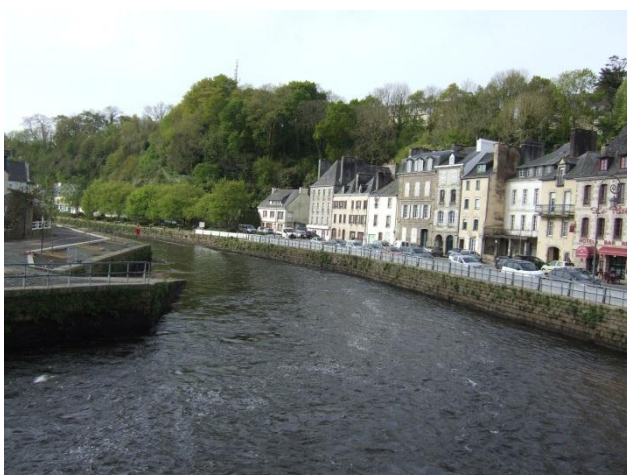
Photos 6 et 7 Batardeaux quai Brizeux, Quimperlé 24 avril 2014
