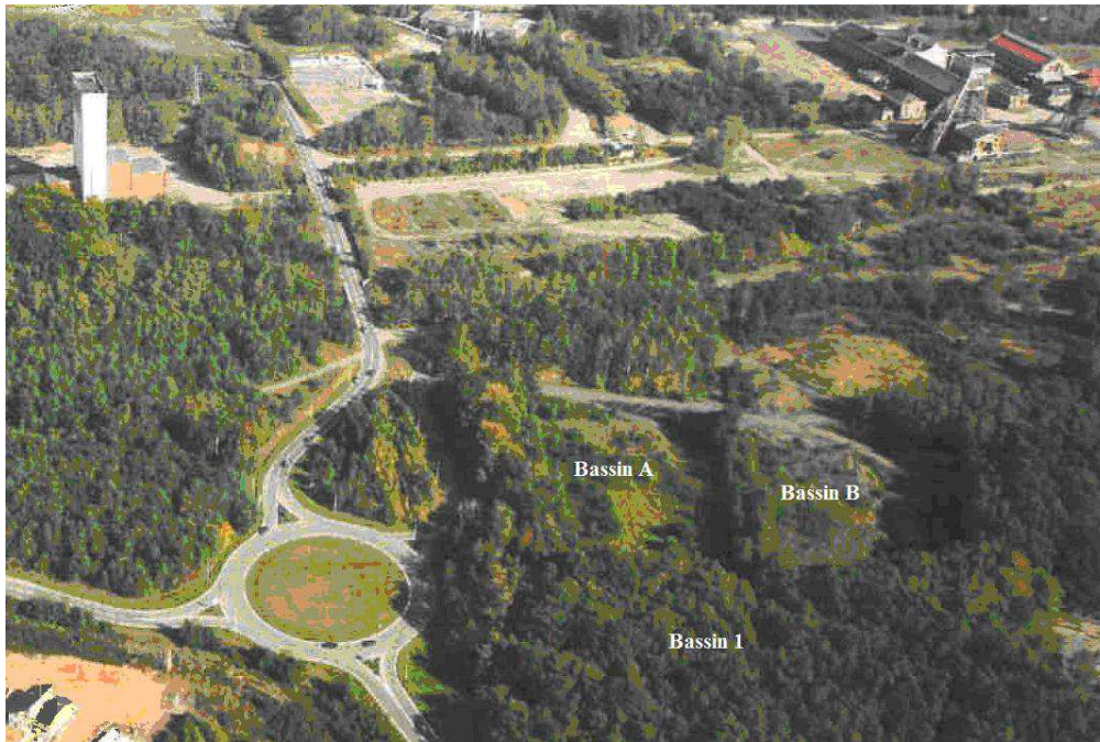
Figure 5 - Vues des bassins A, B, 1 e du Bamag (fin 2007), avant curage, en 2008, des bassins A et B (source CdF)
