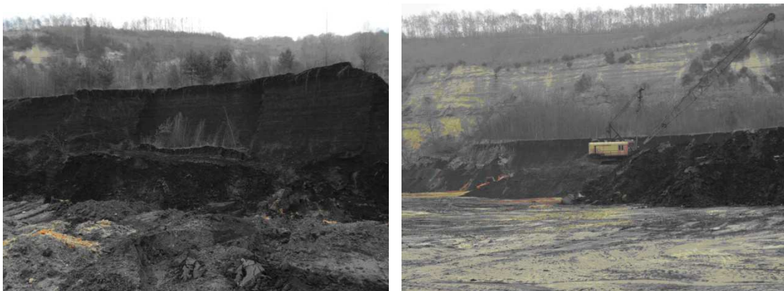
Figure 3 - Exploitation en cours du bassin de schlamms de la carrière Simon (visite site du 4/12/13)
