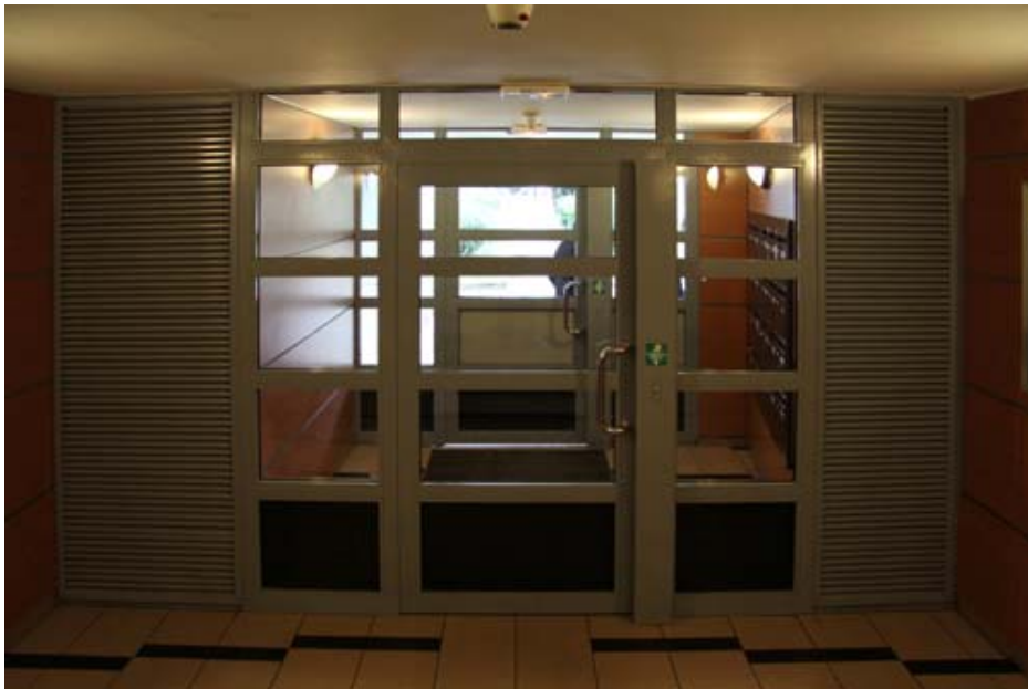
Le sas d'entrée des bâtiments.
