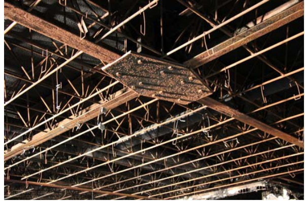
Le plancher, une fois enlevé le faux-plafond. On voit le treillis réticulé et la mise en continuité des poutres de rives de l'élément de plancher.
