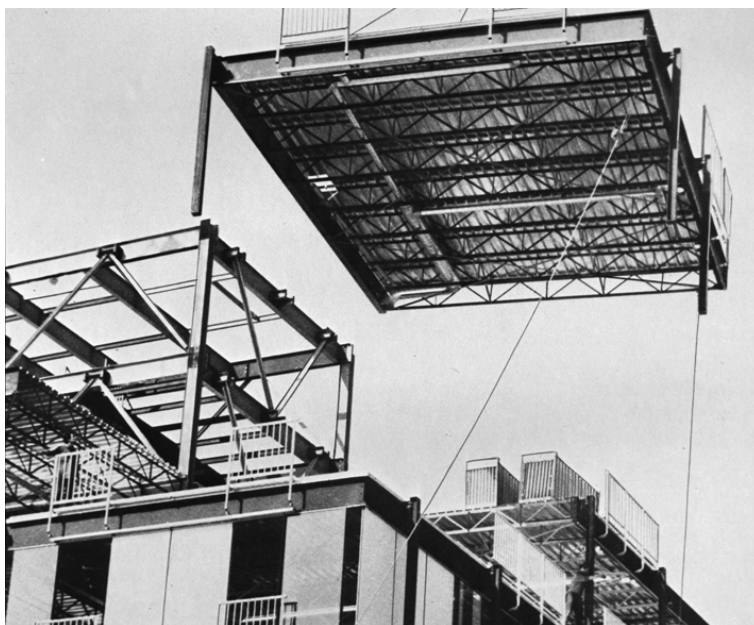
Mise en place d'un élément de plancher du système GEAI. Photographie utilisée en présentation du modèle innovation.
