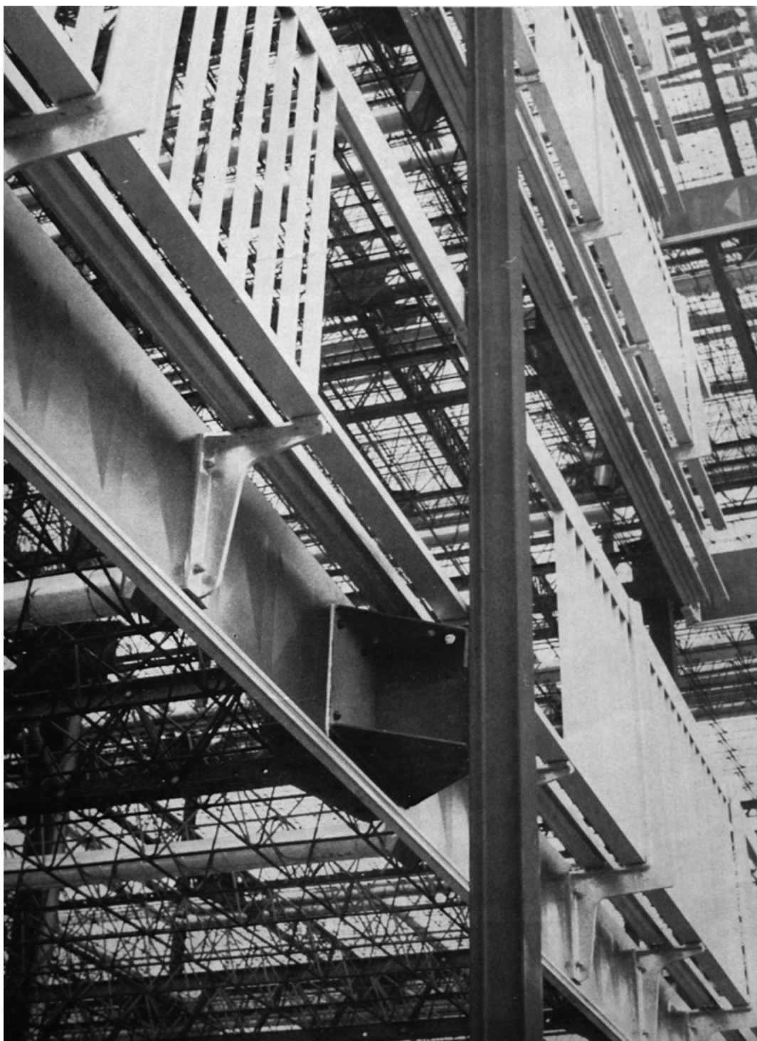
Photographie en cours de construction montrant les éléments de planchers, la tôle périphérique de calfeutrement, le gousset et le poteau, le garde-corps et les rails de guidage. On voit également les conduits horizontaux de chauffage passant dans les treillis.
