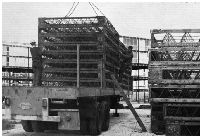
Les éléments de planchers en provenance de l'usine de fabrication.
