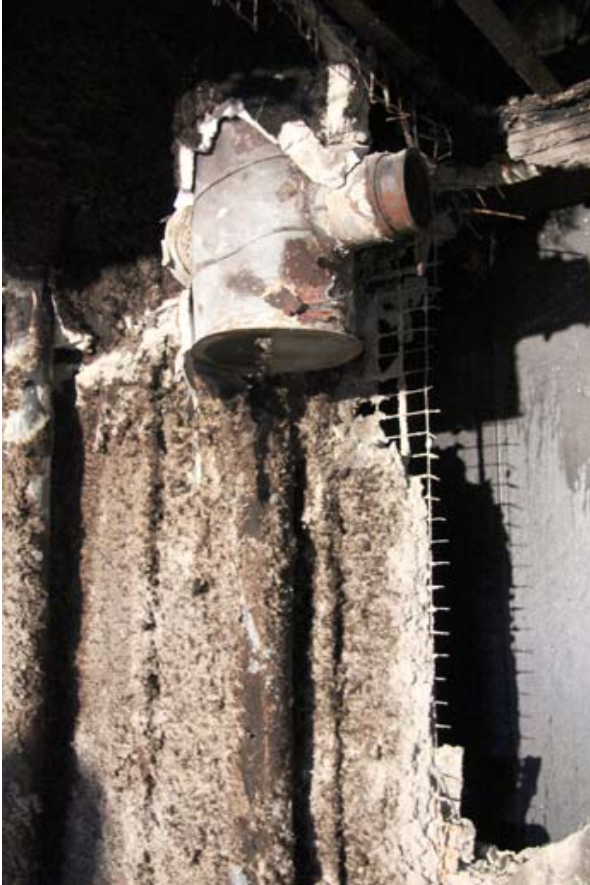
Vue des projections sur nergalto destinées à améliorer la protection au feu de l'assemblage paroi et plafond et de la structure centrale de l'immeuble.
