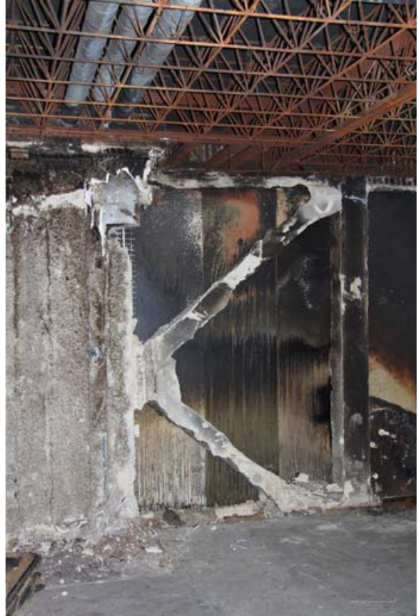
Vue des projections sur nergalto destinées à améliorer la protection au feu de l'assemblage paroi et plafond et de la structure centrale de l'immeuble.
