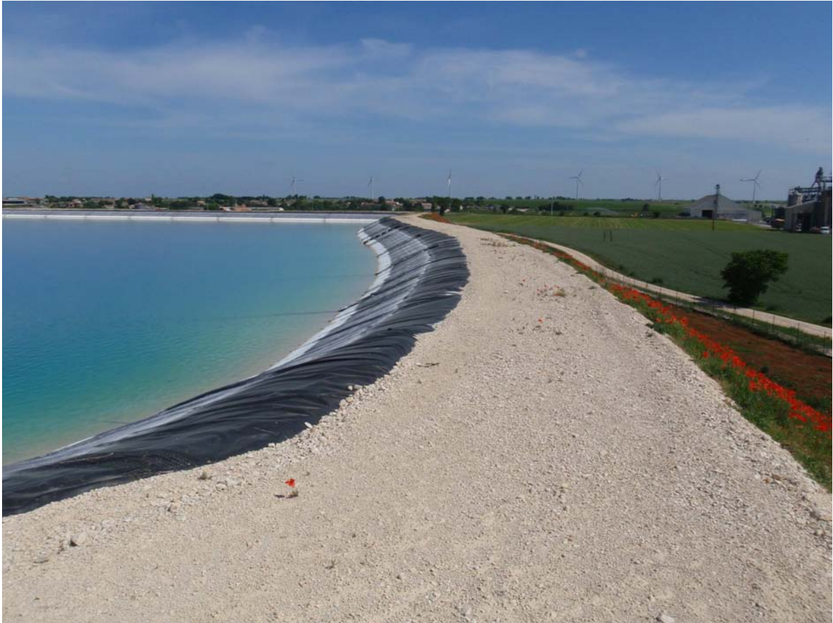
Illustration 23: Un des bassins réalisé en première tranche
