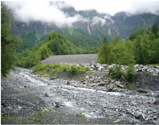
Impact d'un merlon et d'enrochements
